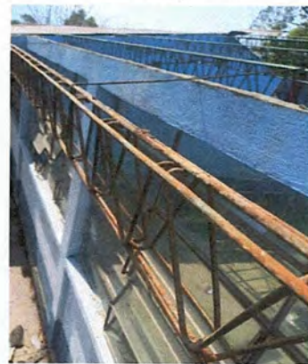
Foto 4: Aulas Despejadas del techo deteriorado
