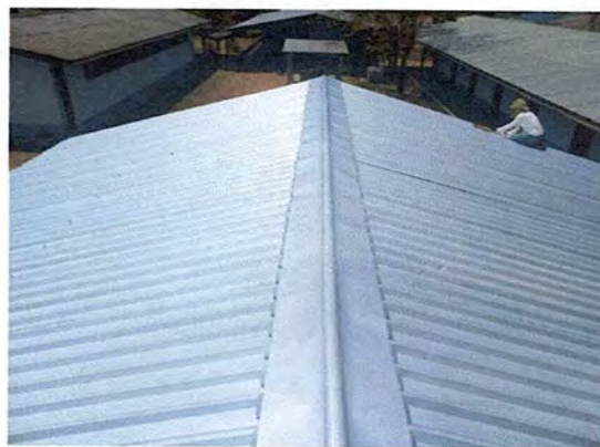
Foto 4: Colocación de Capotes
