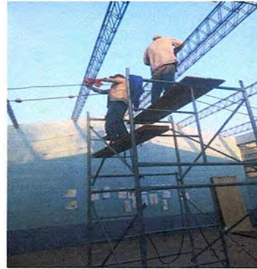
Foto 2: Limpieza de óxido de estructura del techo
