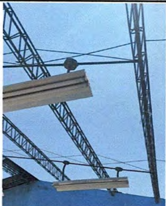
Foto 1: Preparación para la colocación de la lámina
