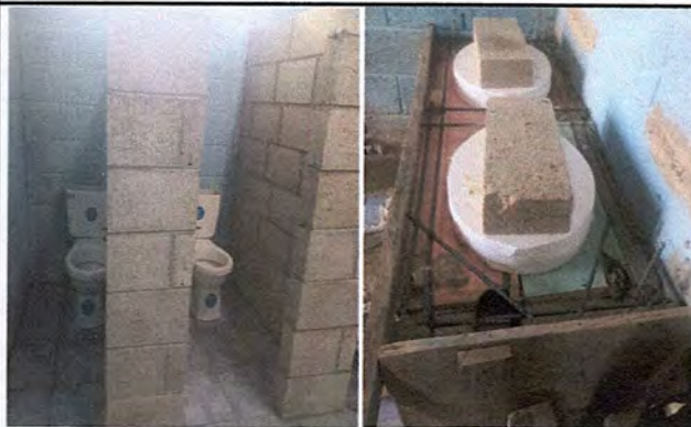
Foto 4: Cambio de Sanitarios, lavamanos y colocación de tabique.
