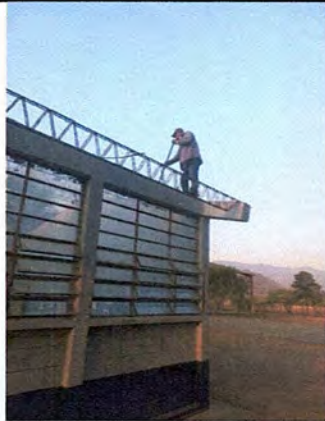
Foto 3: Limpieza de techo
