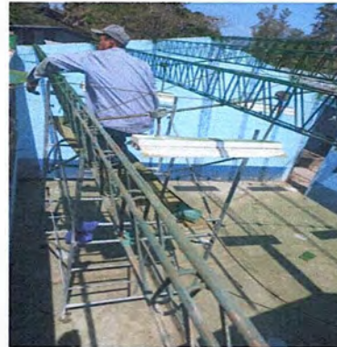
Foto 4: Pintando la estructura del techo
