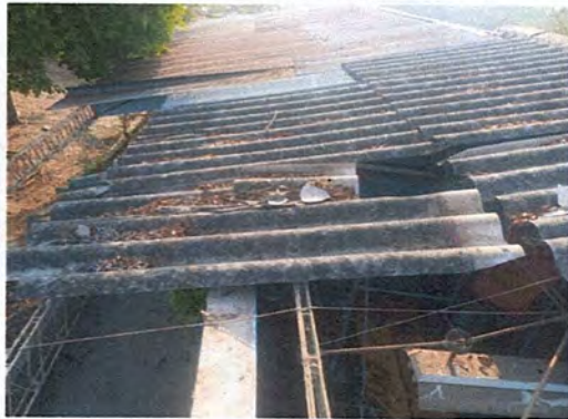
Foto 1: Desmonte del techo deteriorado en los Salones
