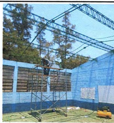
Foto 2: Asegurando estructura para colocación de láminas
