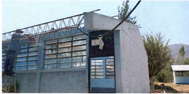
Foto 1: Limpieza a la estructura del techo
