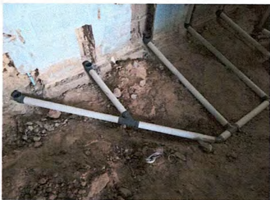
Foto 3: Cambio de Tubería de drenaje e Hidráulica
