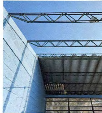
Foto 2: Desmonte de del techo deteriorado
