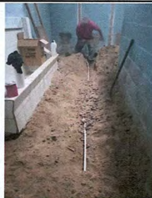
Foto 2: Demolición de Piso
